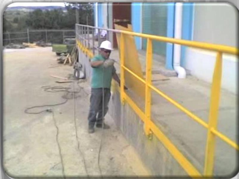
BARANDAL EN PASILLOS A BASE DE PLACA Y TUBO
