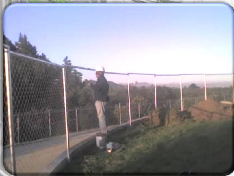
MALLA CICLÓNICA, RELLENO COMPACTADO A 95%, RECUBIERTO CON PASTO NATURAL.
