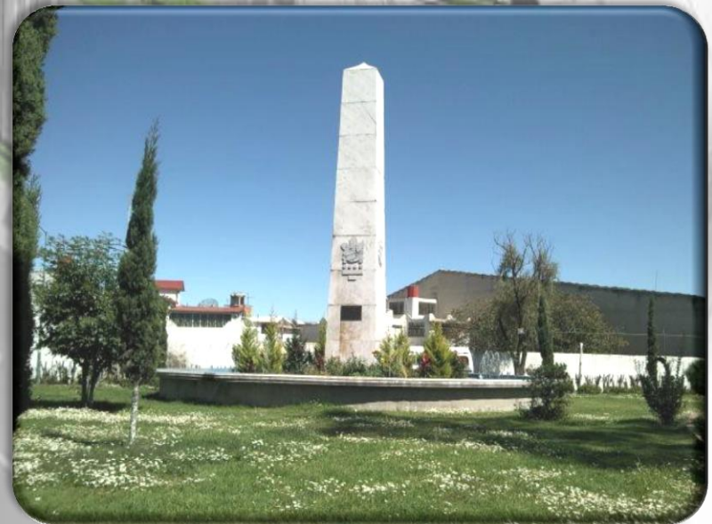
CONSTRUCCIÓN DE FUENTE EN ACCESO SUR
