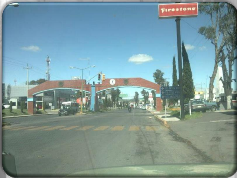
ADECUACIÓN DEL ACCESO SUR
